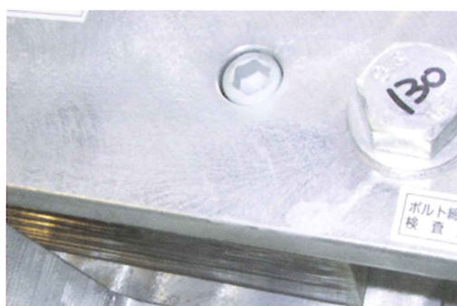
写真5-23. 六角穴付きボルトへのタッチアップ
