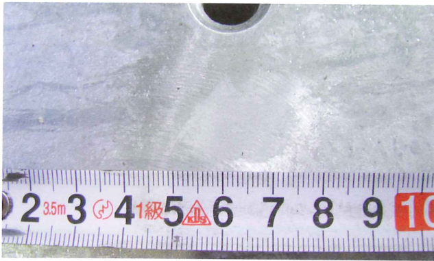
写真5-7. 平面部の膨れの補修例
