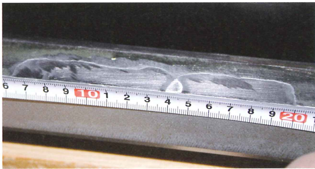
写真5-16. 不めっきによるはく離
