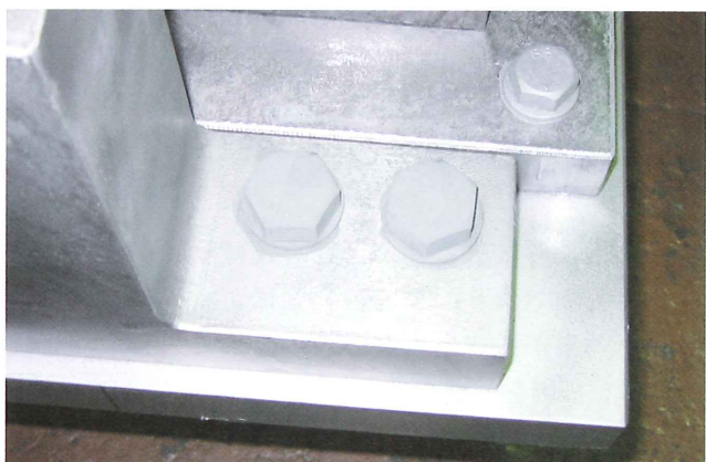
写真5-22. 六角ボルトへのタッチアップ
