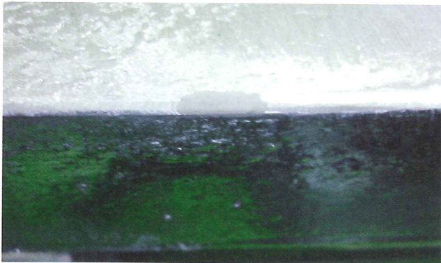
写真5-9. 端部のかけの補修例
