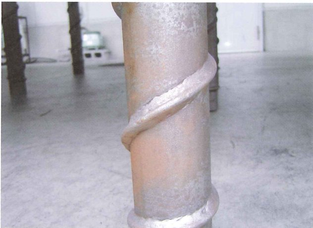
写真6-5. 細径丸鋼の全周溶接
