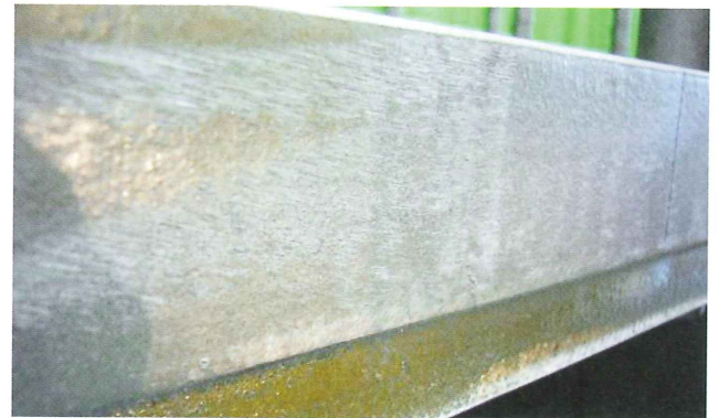
写真5-10. 小口のバフかけ補修例
