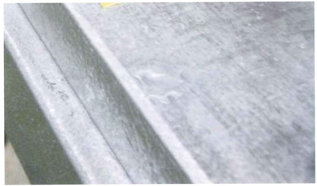
写真5-4. 鋼材の打痕へのめっき
