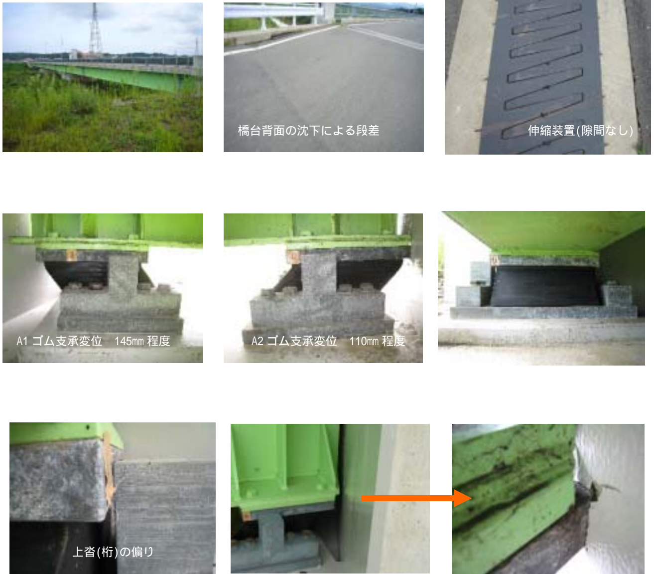
図 2.4 上原一の橋ゴム支承他
