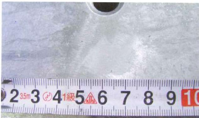
写真5-7. 平面部の膨れの補修例
