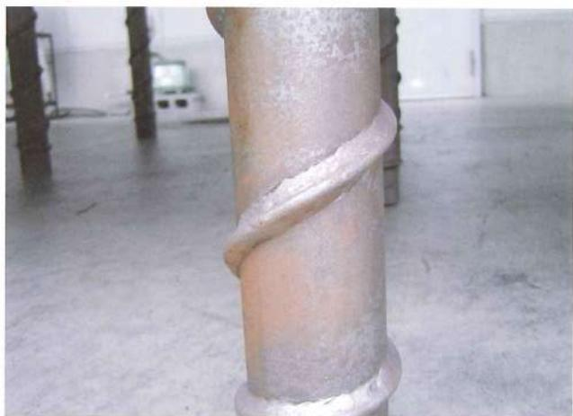
写真6-5. 細径丸鋼の全周溶接
