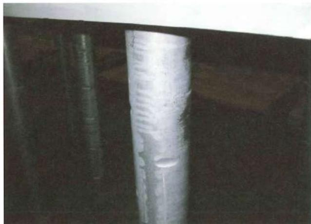
写真6-1. 丸鋼アンカーボルト
