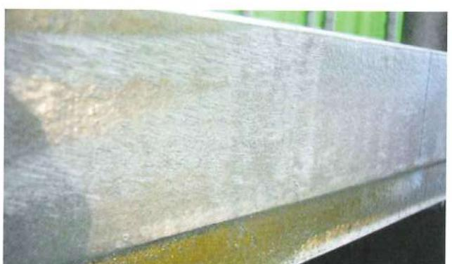
写真5-10. 小口のバフがけ補修例
