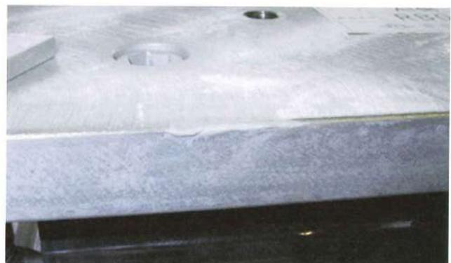
写真5-8. 端部のかけの補修例
